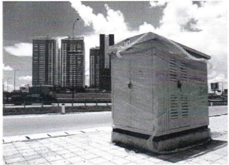
Các trạm biến áp trung thế cho dự án ngầm hóa lưới điện
